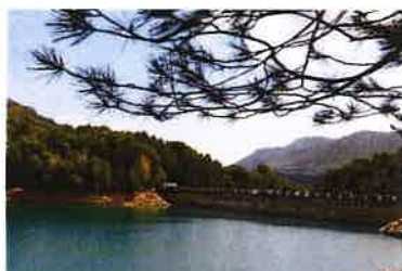
Barrage du Revest les Eaux (Var)
