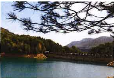
Barrage du Revest les Eaux (Var)
