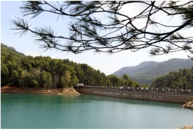
Barrage du Revest les Eaux (Var)
